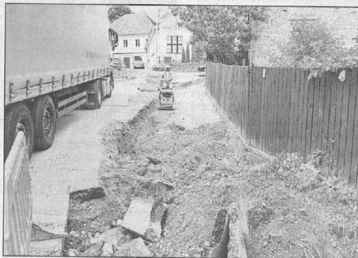
V okolí školy se teď pracuje na chodníku. Vzniknou i nová parkovací místa.
